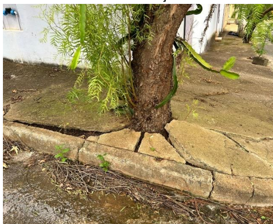
Figura 05: Danos causados pelas raízes da árvore 2 na calçada.
